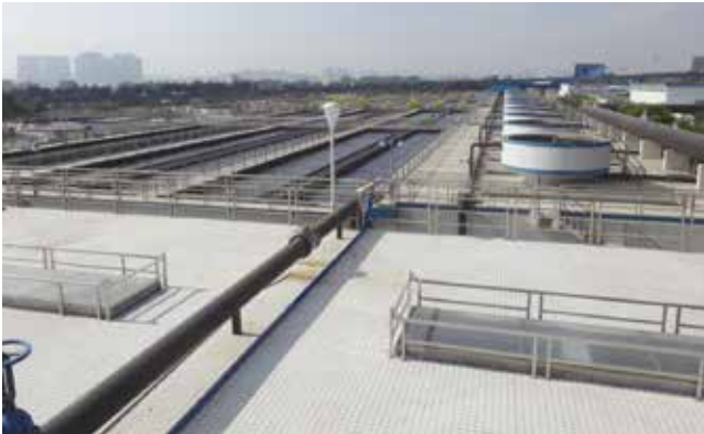
广州市增城永和污水处理厂厂景
