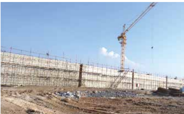
广西玉林节能环保产业基地项目施工现场
