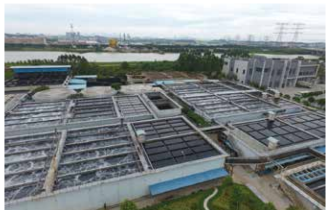
順德港匯污水處理廠
